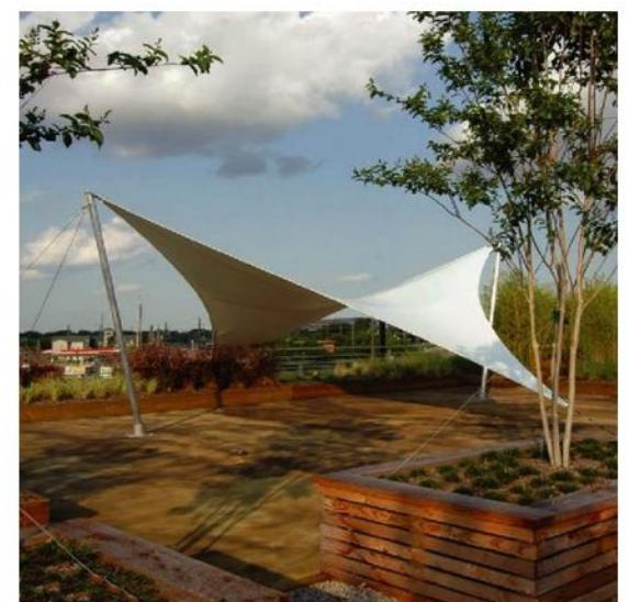
Сцена представляет из себя площадку из деревянного настила, с предусмотренными закладными для установки тентовых конструкций, которые монтируются на время проведения мероприятий.
