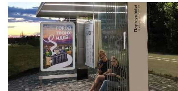
Остановочный павильон на остановке «Парковая»
