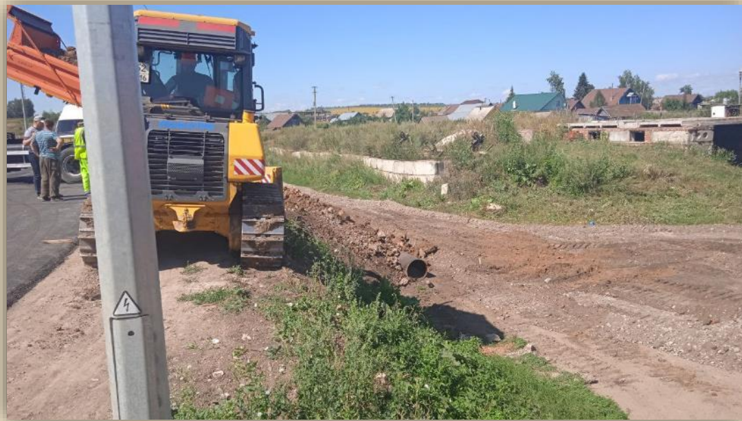
Работы по благоустройству улицы Заречная
